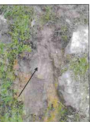
Figure 11 - Tête du forage de reconnaissance affleurant à la surface du chemin. Artésianisme visible.
