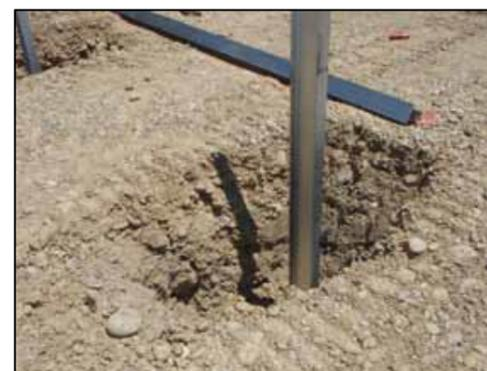
Dans certains types de sol, il est possible d'utiliser des pieux enfoncés dans le sol par le biais d'un enfonce-pieux, sans avoir besoin de fondations béton. Les pieux ou poteaux servant de support sont enfoncés dans le sol sur plusieurs dizaines de centimètres puis recouverts de béton ou non.
