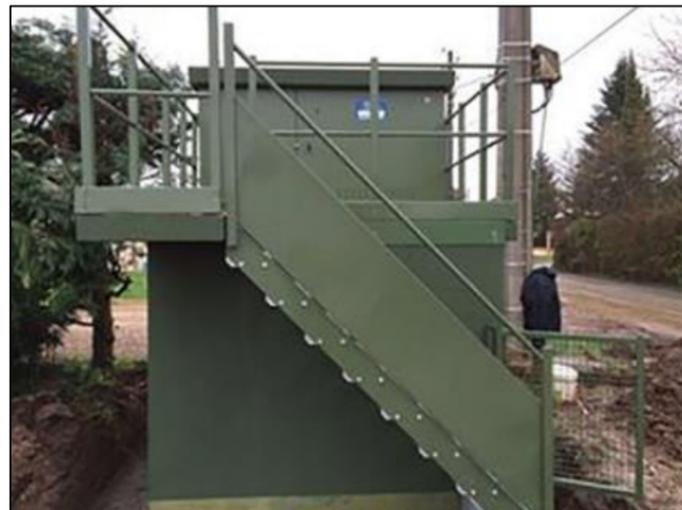
Figure 15 : Exemple de poste de transformation et de livraison HTA/BT réhaussé
