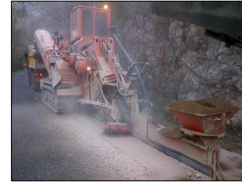
Figure 21 : Photo de trancheuse prise sur chantier
