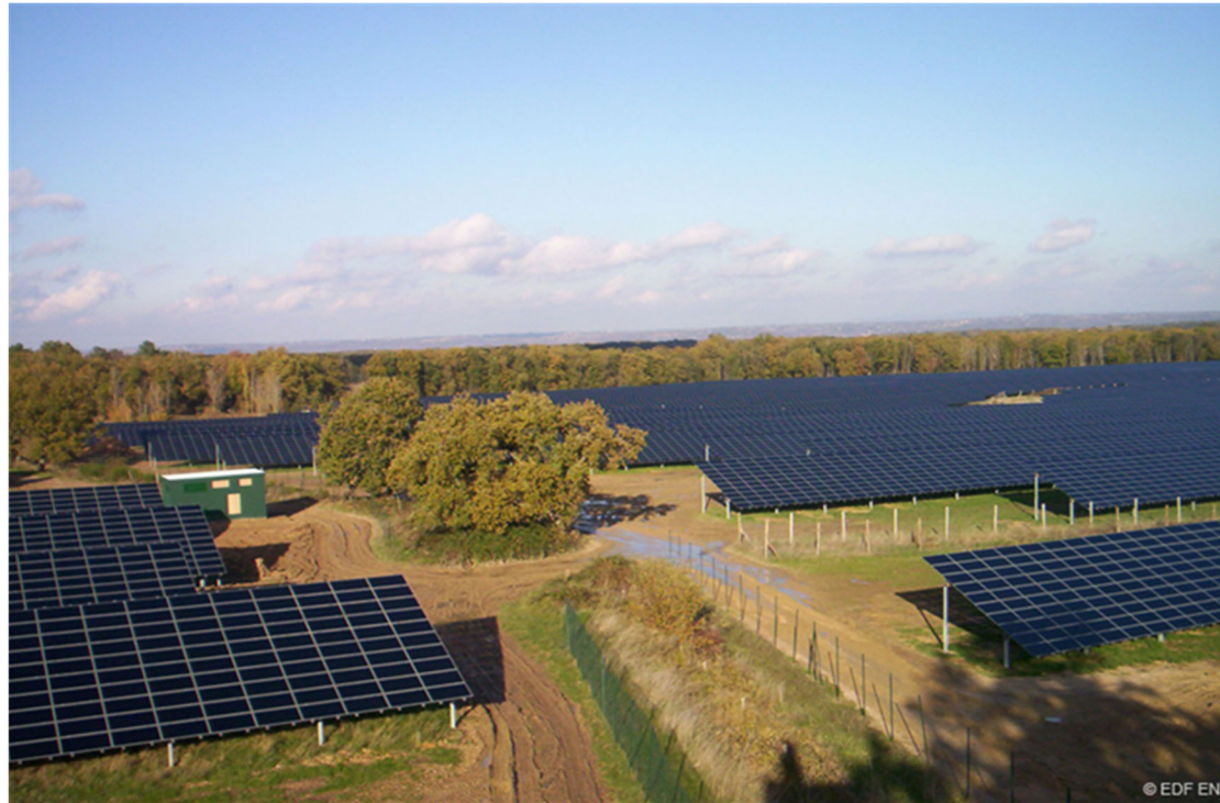
Figure 12 : Fauche différenciée sur la centrale solaire de Narbonne (11) (photo du haut) et corridor écologique préservé en fin de chantier au sein de la centrale de Bouloc (31) (photo du bas)
