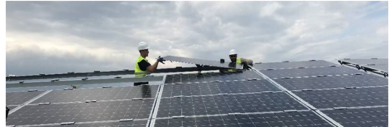
Figure 34 : Pose des modules (Source : EDF Renouvelables)
