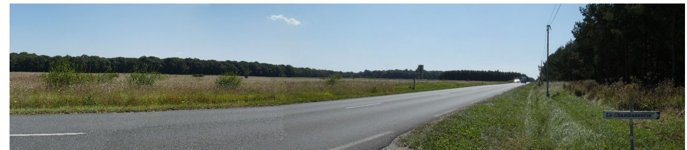
Photo 2 : Vue sur le site du projet au niveau de la RD956 en direction du sud-est
