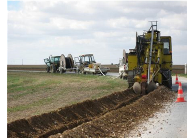
Figure 37 : Réalisation de tranchées du raccordement externe dans l'emprise des voies existantes (Source : EDF Renouvelables)
