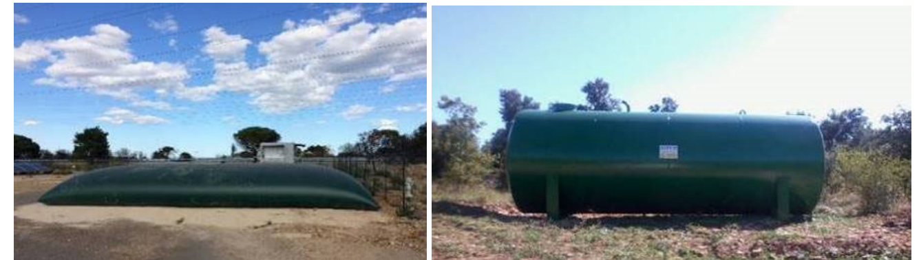
Figure 27 : Exemple d'une citerne souple et d'une citerne en dur (Source : EDF Renouvelables)
