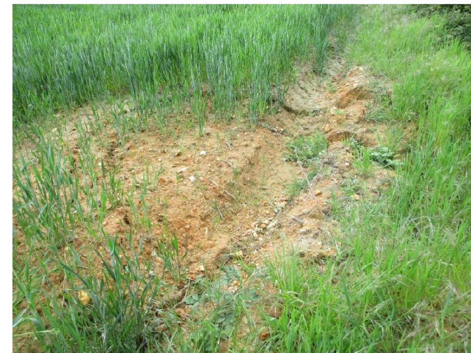
Figure 24 : Loupe de glissement de faible ampleur, au niveau du BV5
